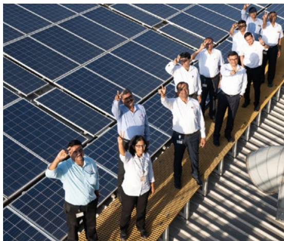
50.000 Solarpanels auf Dächern und Parkplätzen: Der indische Bosch-Standort Nashik setzt auf Sonnenenergie.
